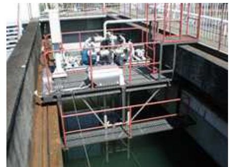
汚泥掻き寄せ機の更新(三島工場)
