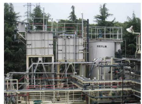
加圧浮上設備更新(小山工場)
